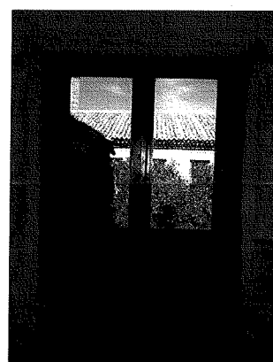
V5 24 uds / planta primera HOJA INTERIOR PRACTICABLE 2 HOJAS / 1'20x1'47 MADERA ACTUAL A RESTAURAR (2ª fase)
